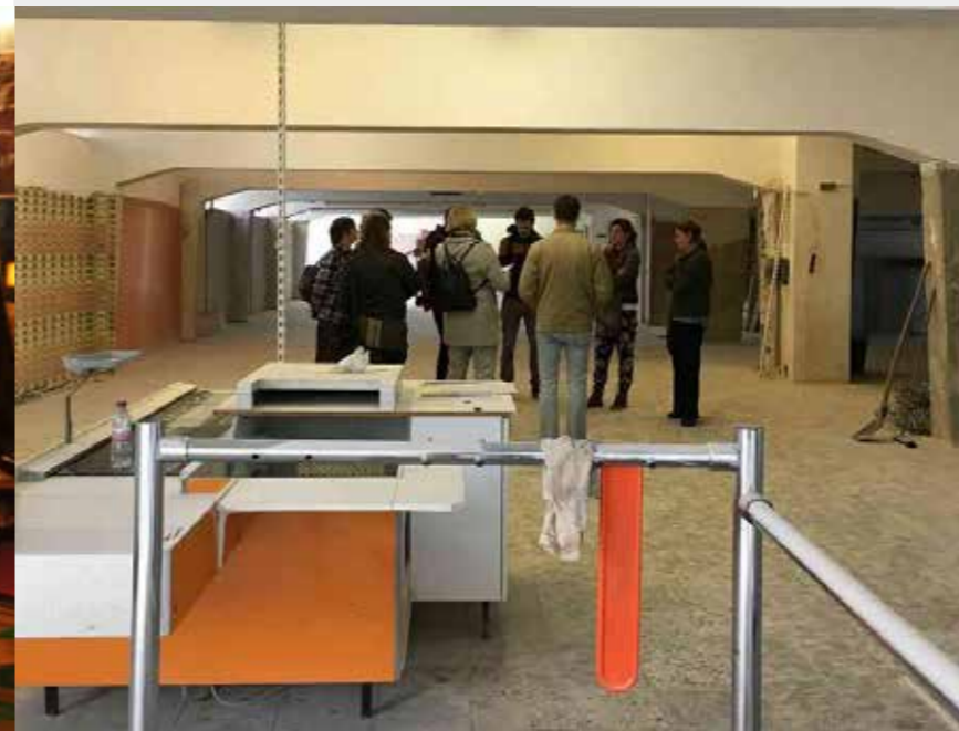
Das »Stapeltor« (seit November 2019) – mit Blick ins Obergeschoss ...
